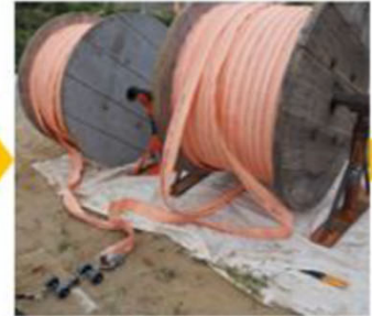
牽引車に繊維さや管を固定
