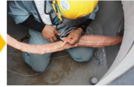
さや管内のケーブル牽引ひもを取り出し
