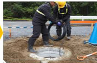
ケーブルの余長確保
