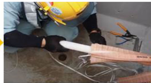
繊維さや管にマンドレルを挿入
