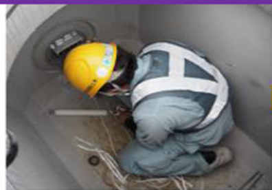
マンドレル（導通試験棒） と牽引ひもを接続
