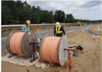
繊維さや管ドラムを設置
