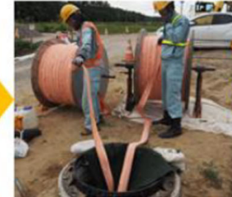
ドラムから繊維さや管を送り出し
