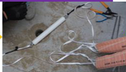
マンドレルの接続完了
