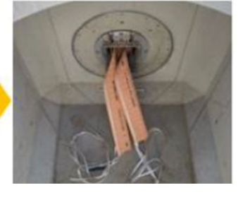
管路端部の処理
