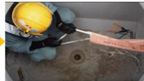
ループ方式でマンドレルを牽引 ひもで牽引し、導通を確認
