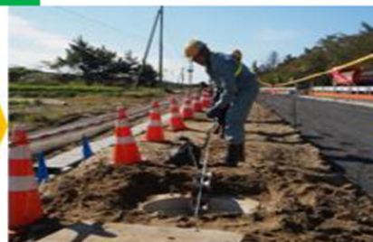
ケーブルの牽引
