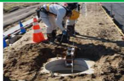
ケーブルの牽引準備
