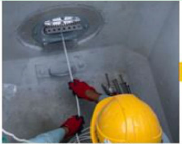
予め通線ロッドを用いて通線した牽引ひもを牽引
