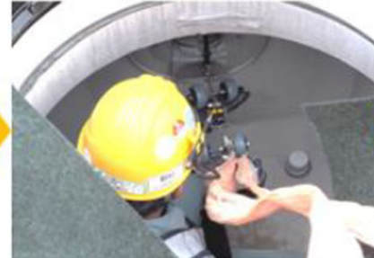
牽引車を管路口に設置
