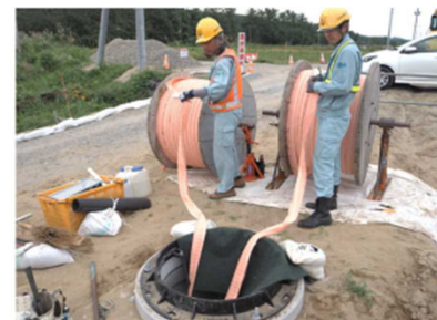
【繊維さや管の施工状況】
