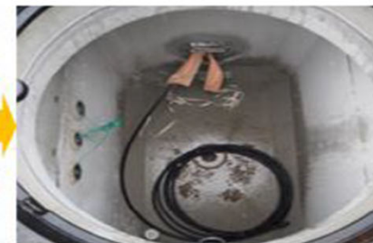
ケーブルの余長収納
