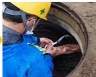
ケーブルと牽引ひもの接続
