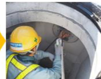
管路口でケーブルに 手を添えて挿入
