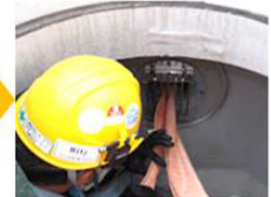
管路口で手を添えてねじれないよう調整
